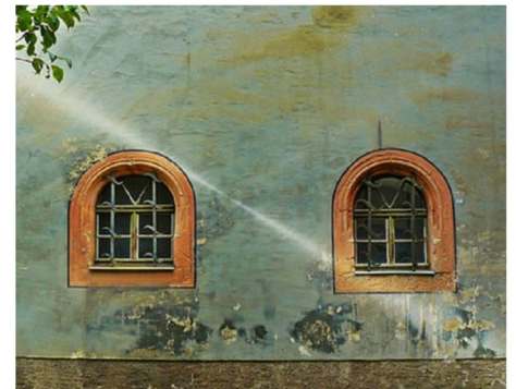
КОРРОЗИЯ КОНСТРУКЦИИ И ФАСАДА ЗДАНИЯ В РЕЗУЛЬТАТЕ ВОЗДЕЙСТВИЯ АТМОСФЕРНЫХ ФАКТОРОВ
