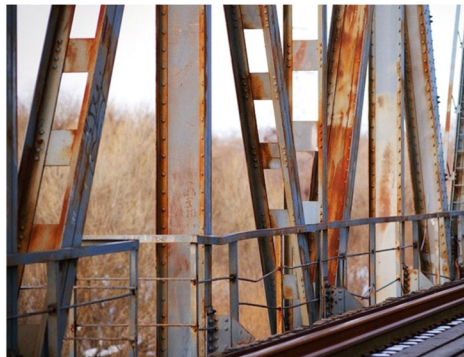
КОРРОЗИЯ КОНСТРУКЦИИ И ФАСАДА ЗДАНИЯ В РЕЗУЛЬТАТЕ ВОЗДЕЙСТВИЯ АТМОСФЕРНЫХ ФАКТОРОВ
