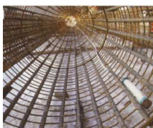
Рис.10.6. Примеры установки датчиков для определения усилий в арматуре различных конструкций и общего вида измерительных приборов: а – тензометрические датчики, смонтированные на арматуру плиты в двух направлениях перед бетонированием; б – струнный датчик для определения усилий в бетоне буронабивной сваи; в – тензодинамометр и вторичный прибор для определения усилий в бетоне забивной сваи
